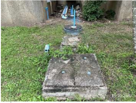
ภาพที่ 2.2-4 บ่อเกรอะ-บ่อซึม และถังกรองไร้อากาศ ที่อาคารปฏิบัติงาน
